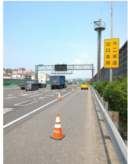
同時決定於原計劃架設之 **0A** 系列雷達型號 **T 29** 外，並將原廠新近發佈之 **3DHD 0C** 系列 **T42** 其追蹤目標 4 倍高於 **T29** 之兩種不同系列雷達，併列架設並施以同步測試。主要想予以確認在此一交通量頻繁且常有車輛走走停停路段，兩個不同系列雷達之功能特性。因 **0A T29** 雷達雖然其鎖定追蹤處理車輛物件，已可達截至目前雷達業界最高之 **64** 只，然此新一代 **0C T42** 雷達處理容量則更高達 **4** 倍 **256** 只，因此擬藉此測試了解此一新一代雷達之需求性與必要性，暨於此一 **Stop & Go** 走走停停路段，其與環路線圈車輛偵測器於當車輛速度低於 **30** 公里就會流失其準確性之不同功能特性。
